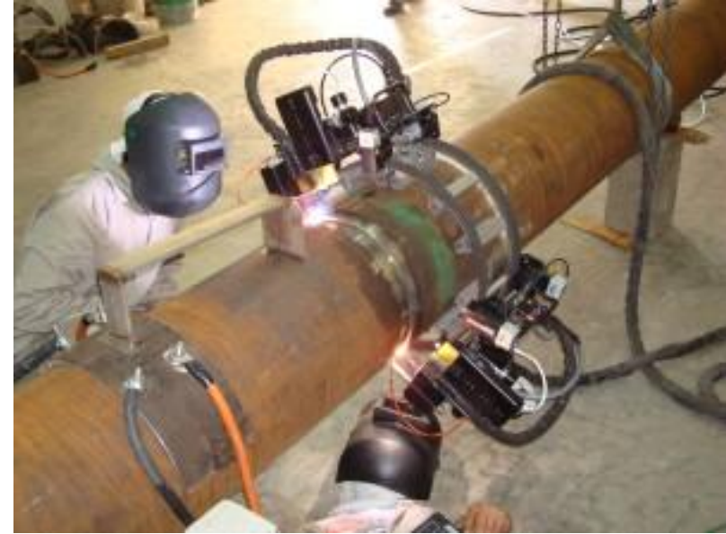
Deniz dibine döşenen LNG Borusu otomatik kaynağı. Çap: 50 cm, Et kalınlığı 36 mm. Kaynaktan sonra NDT ve boru üzeri 4 mm Epoksi kaplanıyor.
