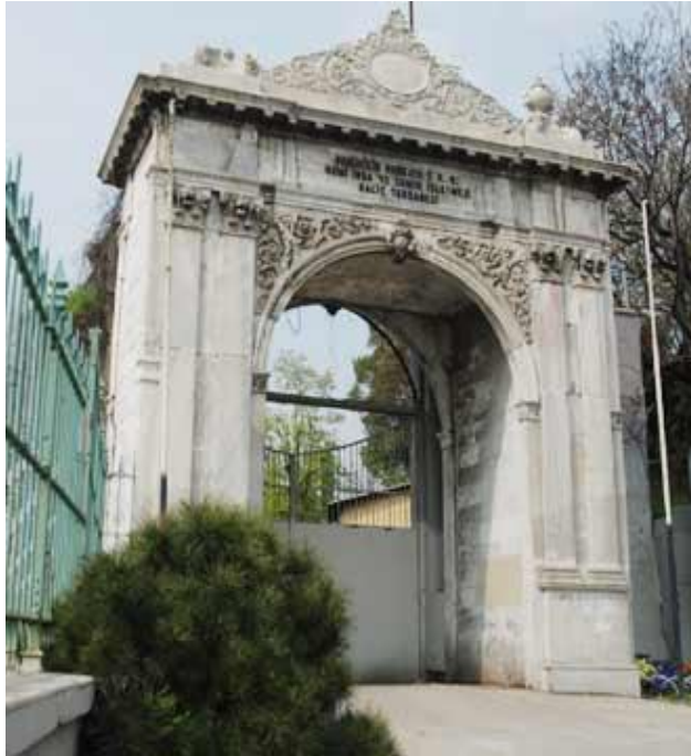
Tersane giriş kapısı
